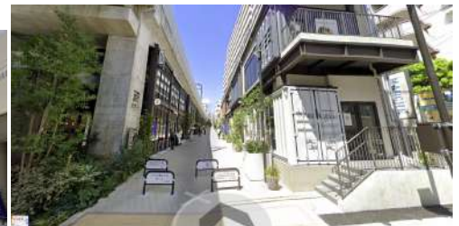
D 線路街(井の頭線ガード)洒落た2階建商業)
